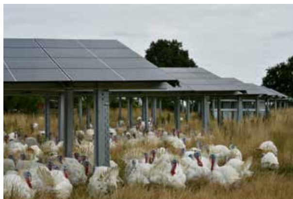
Dans les Deux-Sèvres, les panneaux photovoltaïques servent d'ombrières aux dindons de l'élevage de Nicolas Moreau ©CRNA/F.Roch
