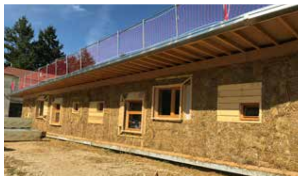
Construction en matériaux bio-sourcés au lycée agricole de Venours ©CRNA/L. Bussy
